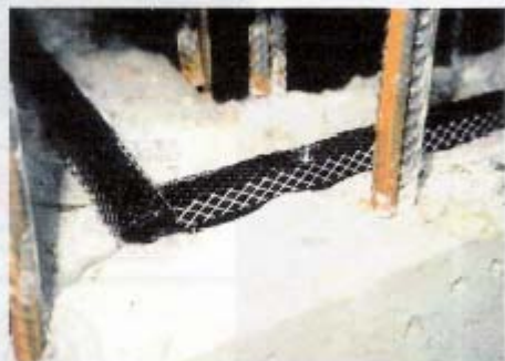
Detalle de unión en ángulo
