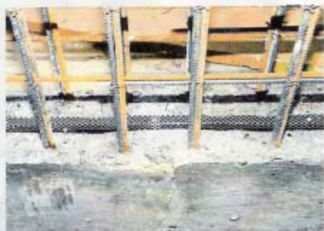
Detalle de colocación
